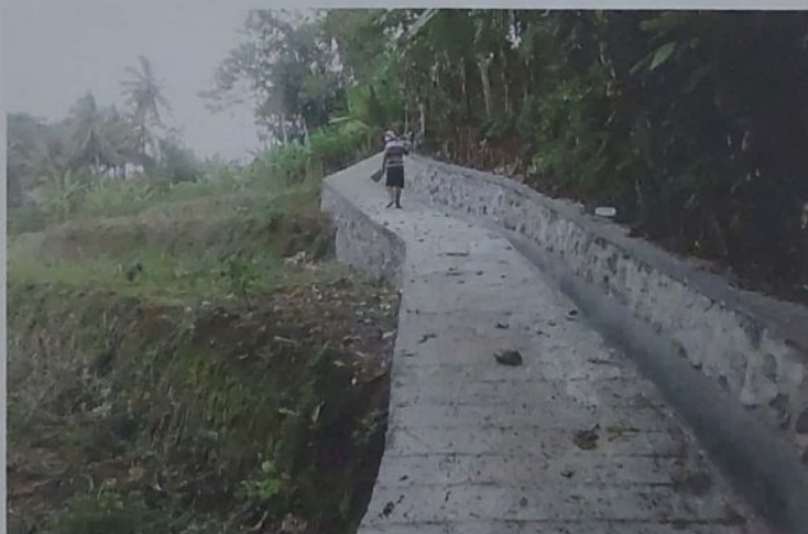
100 % Pekerjaan Jalan Usaha Tani Sedelen
