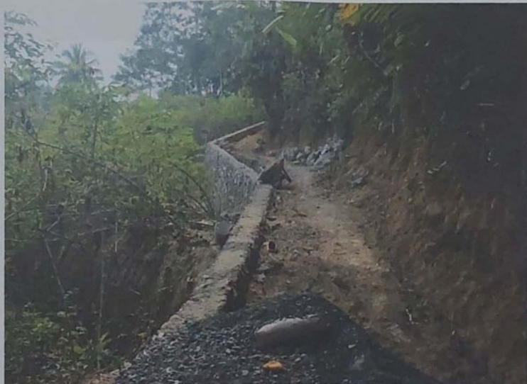
50 % Pekerjaan Jalan Usaha Tani Sedelen
