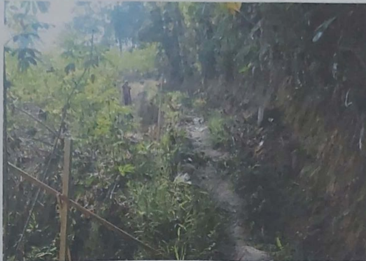
0 % Pekerjaan Jalan Usaha Tani Sedelen
